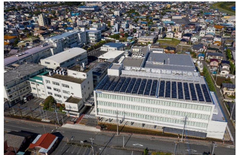
太陽光発電システム（ミツバ研究開発センター）
